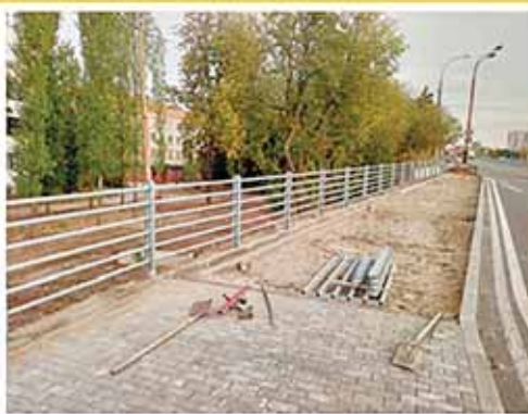
- МОНТАЖ ПЕРИЛЬНОГО ОГРАЖДЕНИЯ - СТРОИТЕЛЬСТВО ТРОТУАРНОЙ СЕТИ ВДОЛЬ ЭСТАКАДЫ
