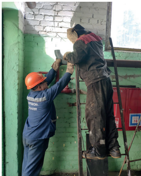
Замена участка трубопровода, Ду-100мм на котельной, ул. Кирова, д.34, стр.1
