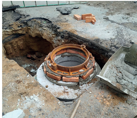
Капитальный ремонт канализационных колодцев р.п. Малаховка, ул. Фрунзе
