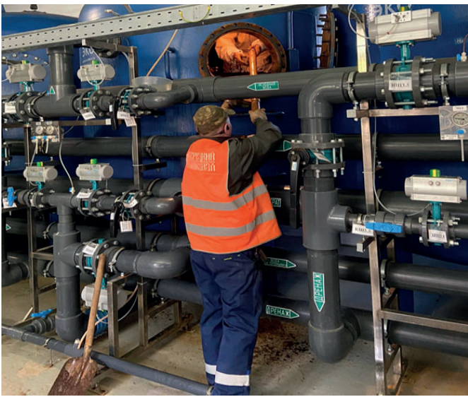
Проведение профилактических работ на ВЗУ 12
