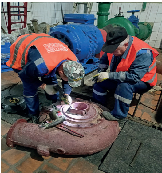
Ремонт насоса на КНС Звезда, АО «Люберецкий Водоканал»
