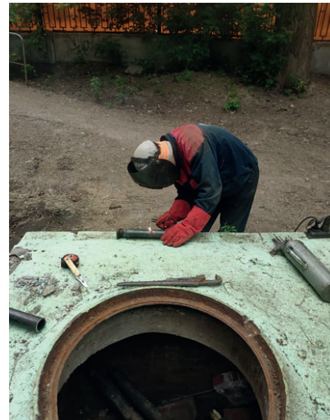
Замена запорной арматуры, Ду-40, Ду-32, в тепловой камере на ул. Кирова
