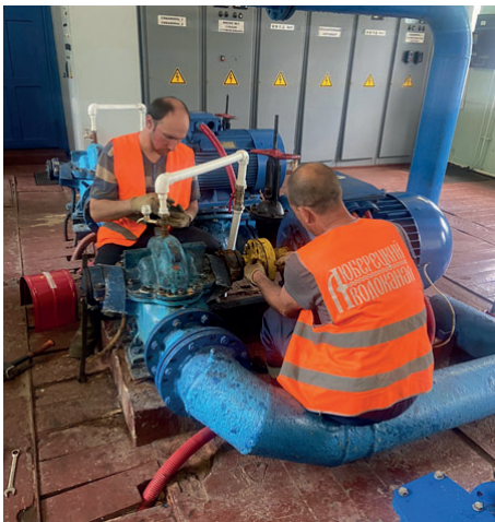
Ремонт насоса 2-го подъема, ВЗУ Малаховка
