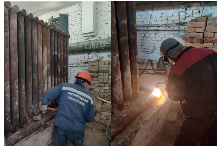
Капитальный ремонт котлов, ЗИО-60, ул. Власова, д.3, строение 1
