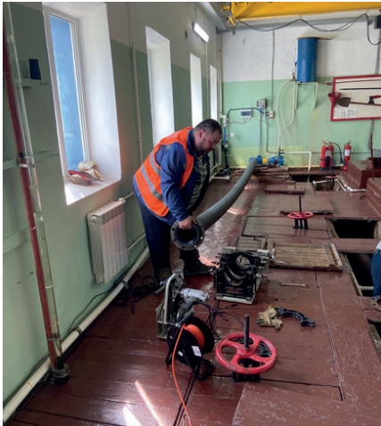
Ремонт насоса 2-го подъема, ВЗУ Малаховка
