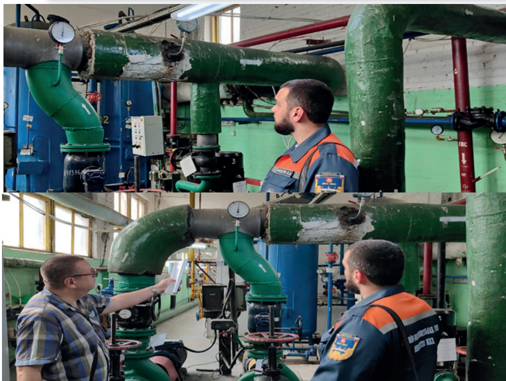
Проведение гидравлических испытаний тепловых сетей котельной № 303 совместно с ГКУ МО МОС АВС, ул. Кирова, д.34
