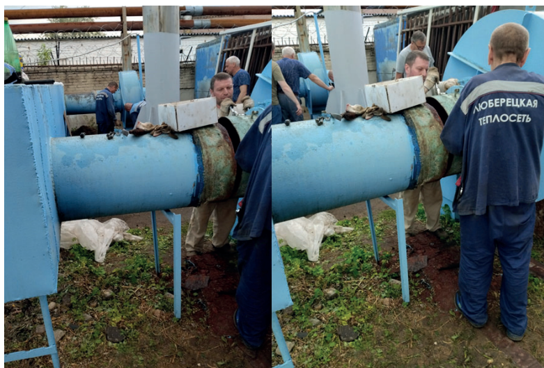
Ремонт дымососа, Хлебозаводской проезд, д.3
