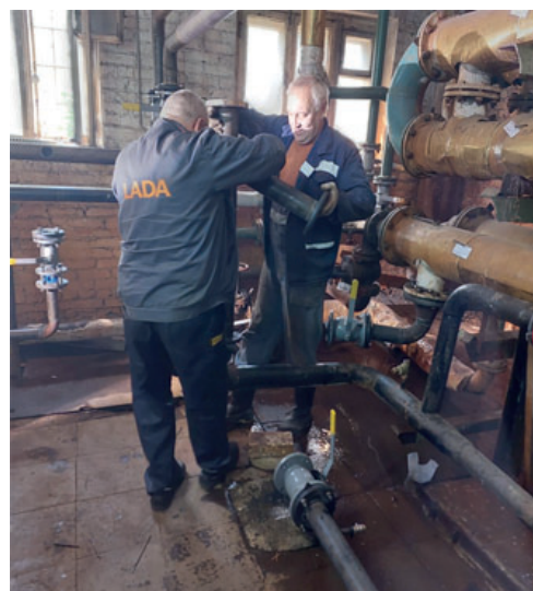
Установка нового теплообменника ГВС р.п. Малаховка, ул. Калинина, д.29
