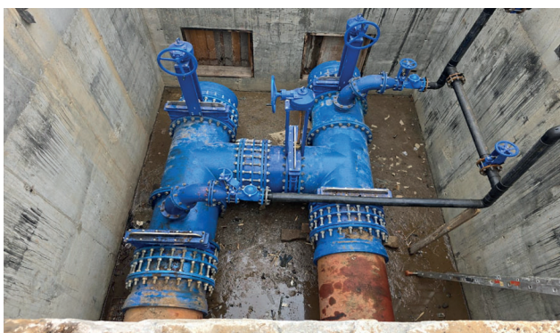
Строительство камеры на напорном трубопроводе, Ду-800 мм, От КНС Звезда до очистных сооружений
