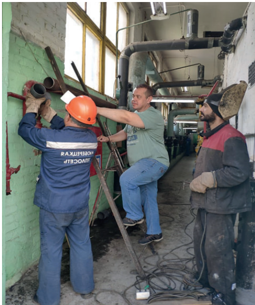
Замена участка трубопровода, Ду-100мм на котельной, ул. Кирова, д.34, стр.1
