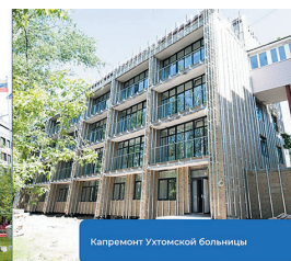
Капремонт Ухтомской больницы
